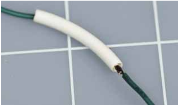
Рис. 3.41. Натяните трубку на соединение проводов
